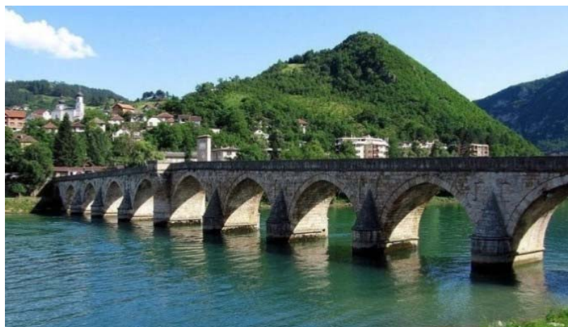
Visegrad, il ponte sul fiume Drina - Foto tratta da Wikipedia 01.04.2009
